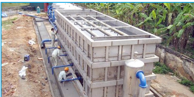
BỂ LẮNG LAMEN LAMEN SEDIMENTATION TANK
